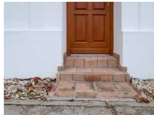
▲ Pédaértékűen felújított lábazat és lépcső
