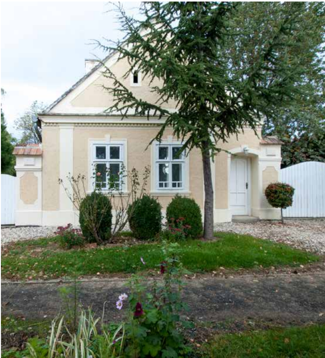
▲ Példaértékű épületmegújítás, gondozott közterülettel. Figyeljük meg a hagyományos habarcsolt szélső cserépsort!
